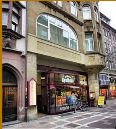
Haus Rosgartenstrasse 16 heute (2008)
